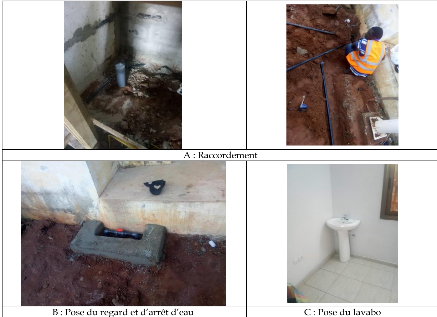
Photo 10 : Raccordement et pose des équipements de plomberie
