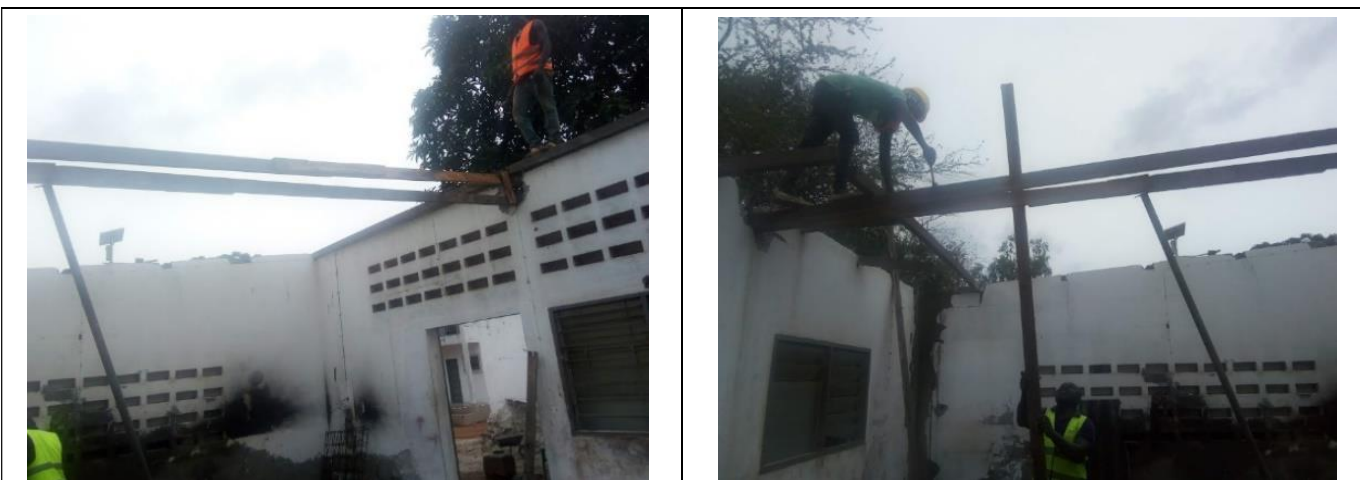
A : Pose de la charpente à bois traités
