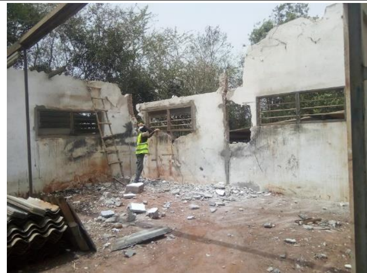
C : Démolition des pans du mûr
