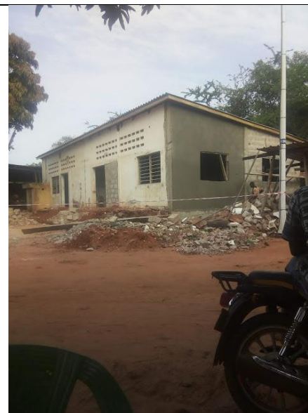
C : Fin de la pose de la toiture
