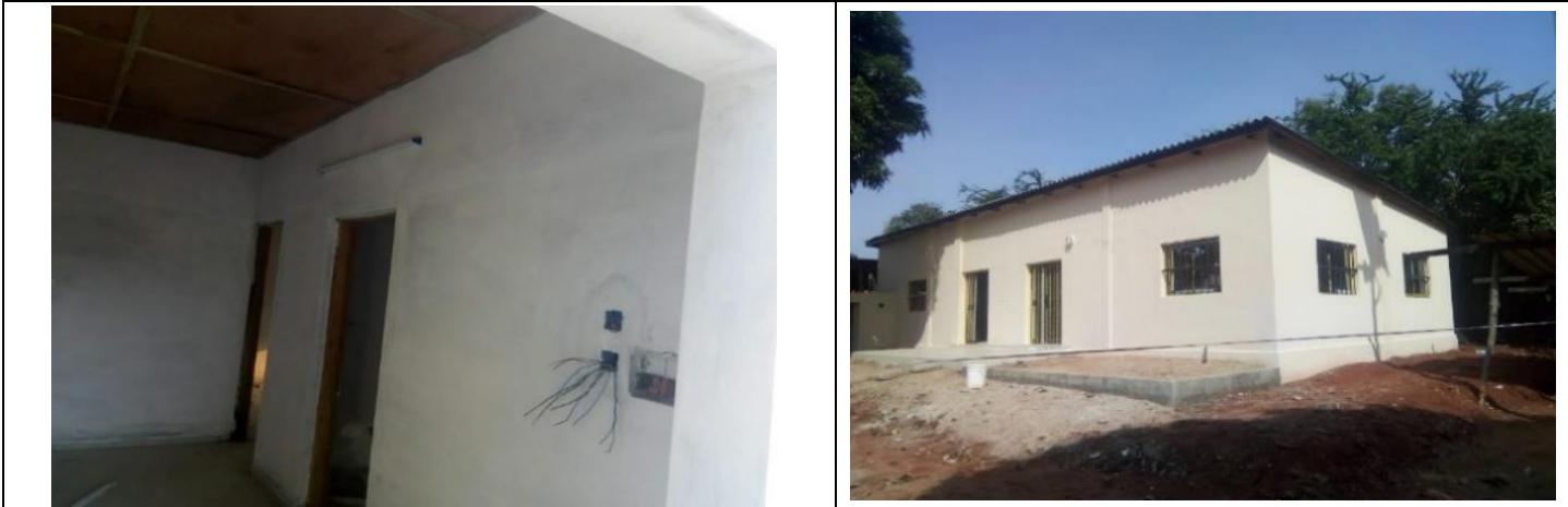
B : Evolution et fin des travaux de peinture
