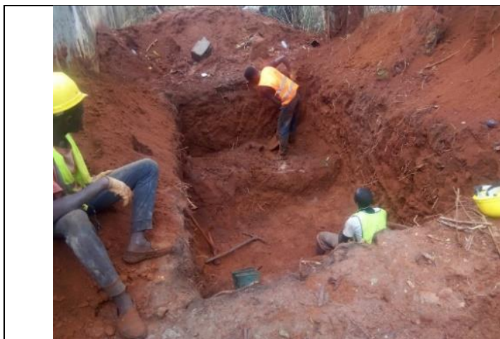
A : Début de la construction des fosses
