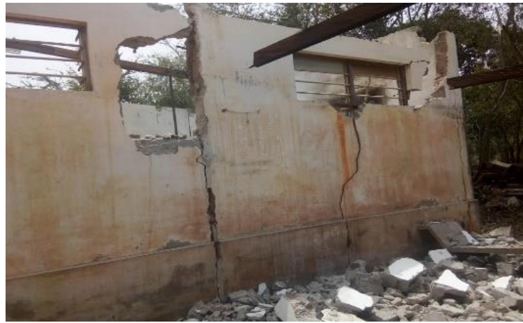
A : Démolition des fenêtres
