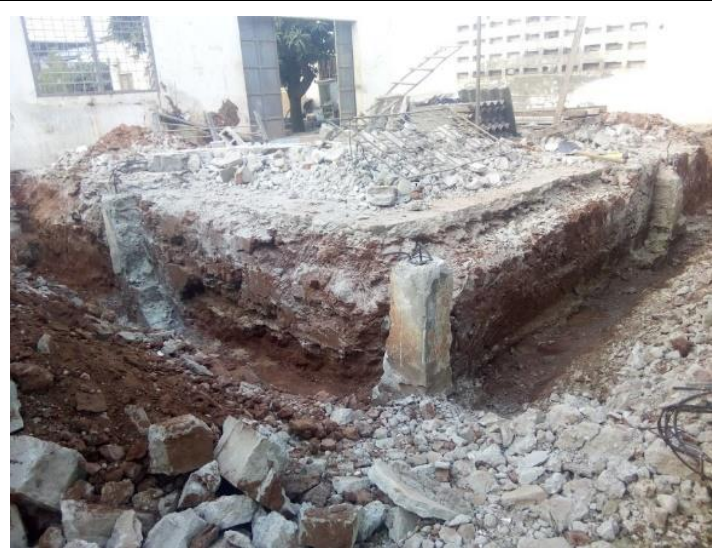
D : Fin de la Démolition
