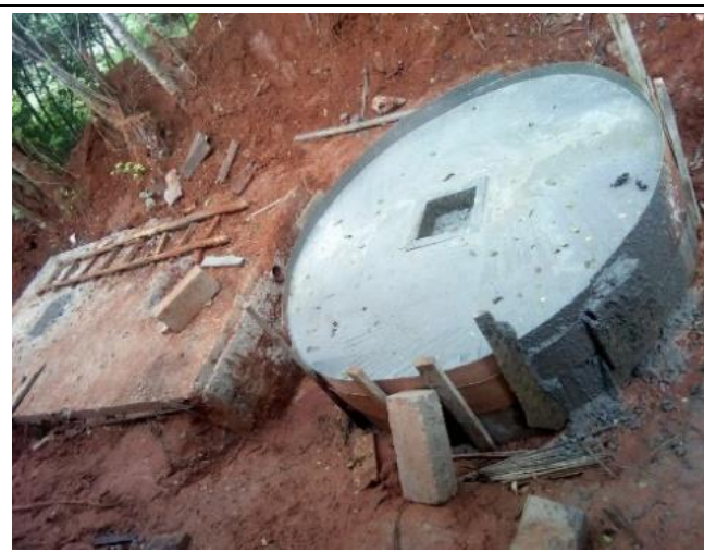
D : Fin de la construction du puisard
