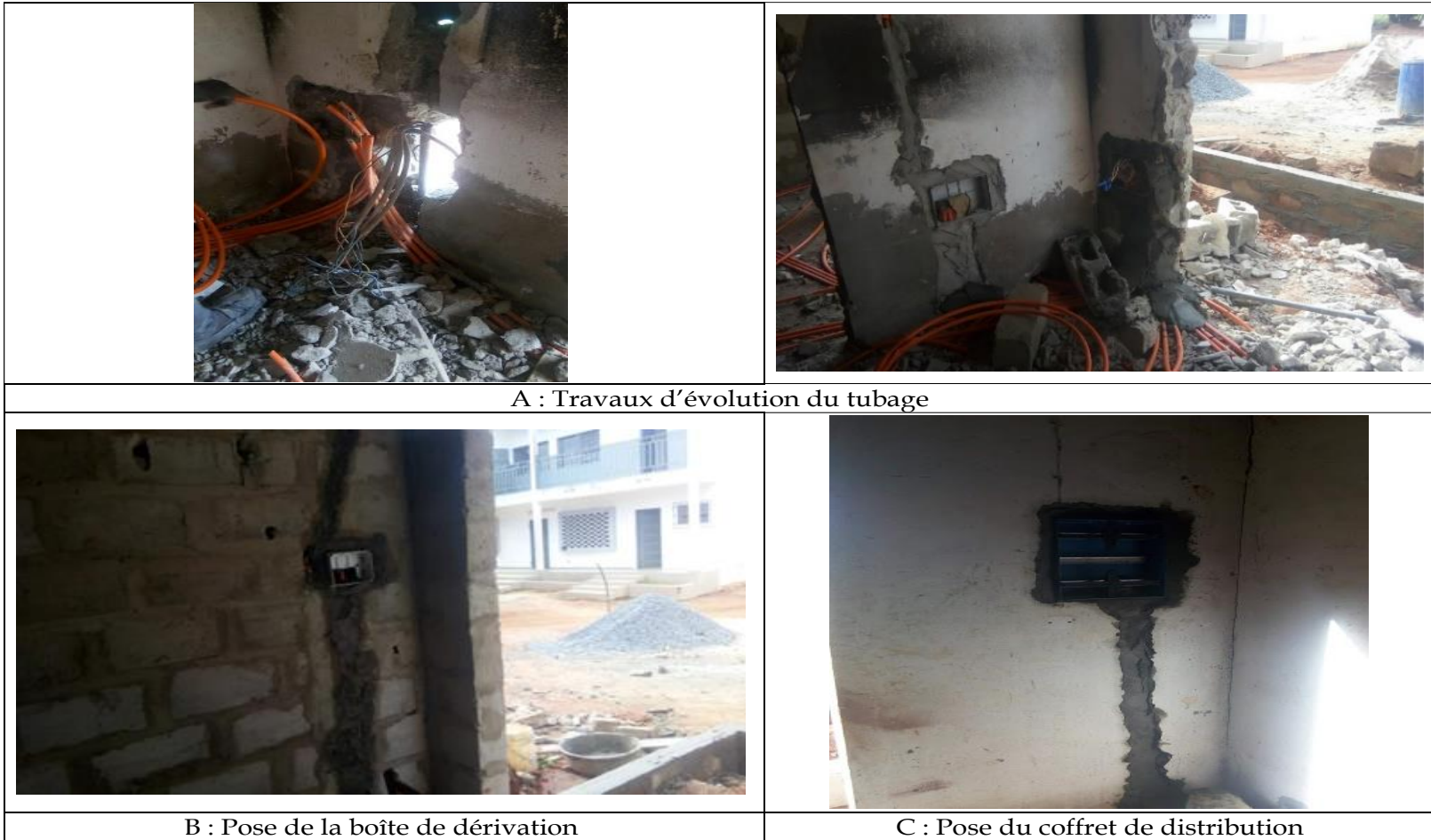
Photo 8 : Réservations et tubage pour électricité
