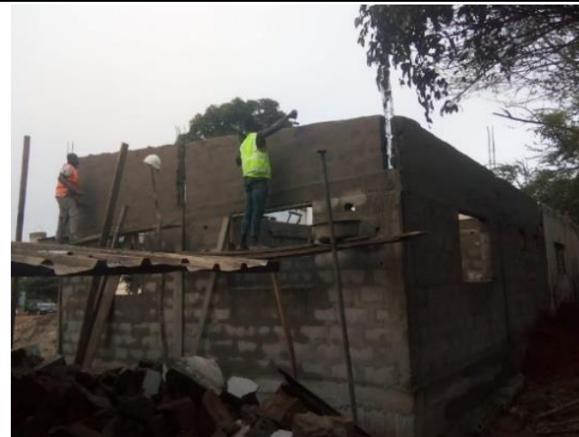
D : Elévation après chaînage
