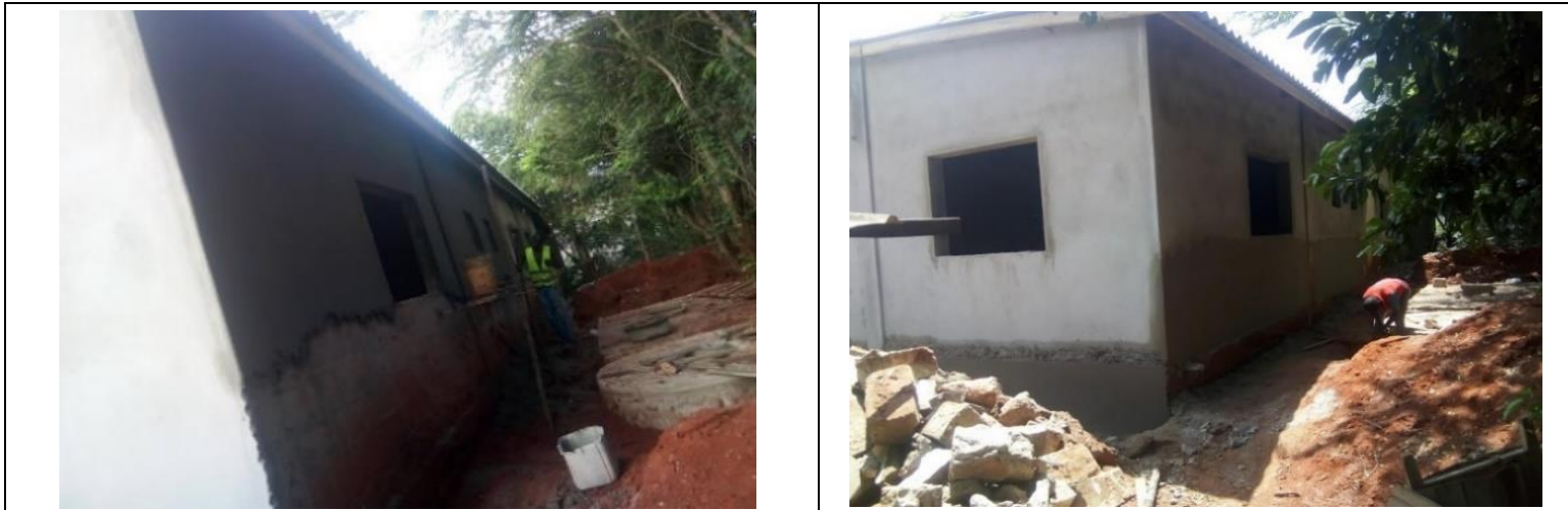
A : Début de la réalisation de l'enduit ciment
