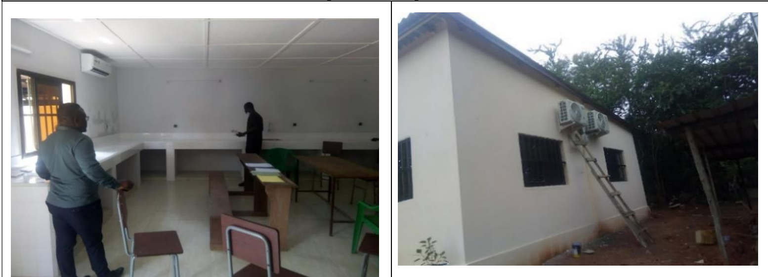
B : Fin de la pose des récepteurs d'air conditionné
