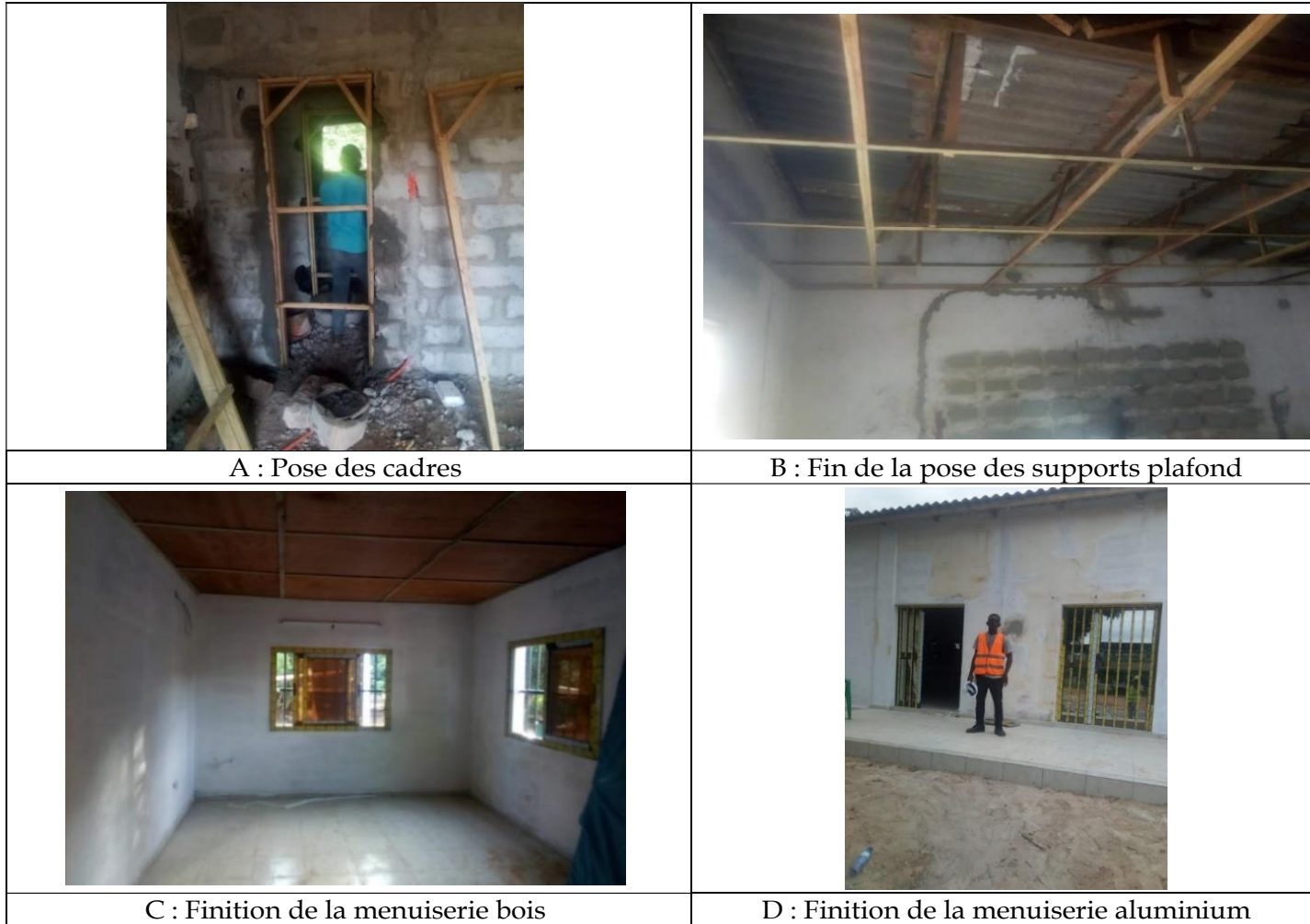
Photo 9 : Pose des éléments de menuiserie (Bois et Aluminium)
