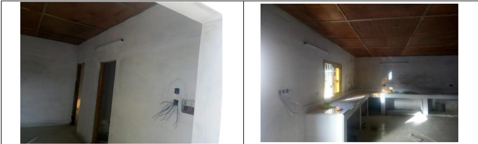
A : Filerie et pose des récepteurs lumineux
