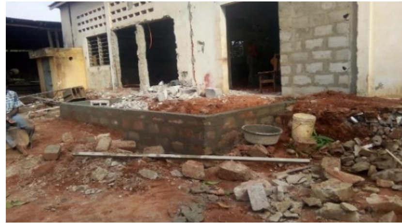
B : Fin de la fondation et remblai
