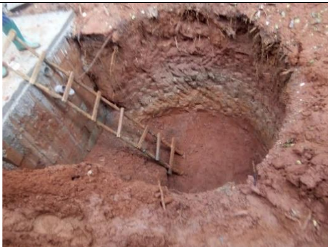
C : Début de la construction du puisard
