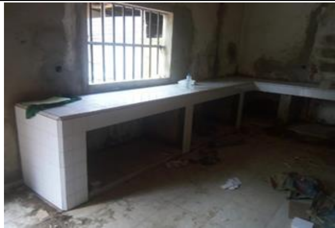
C : Pose des carreaux
