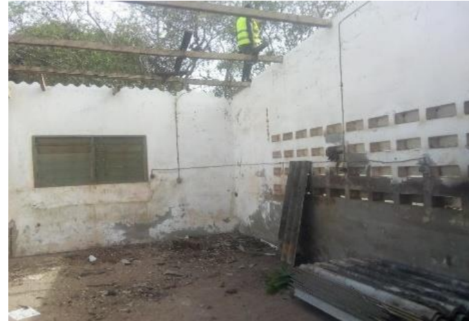
B : Démolition de la toiture
