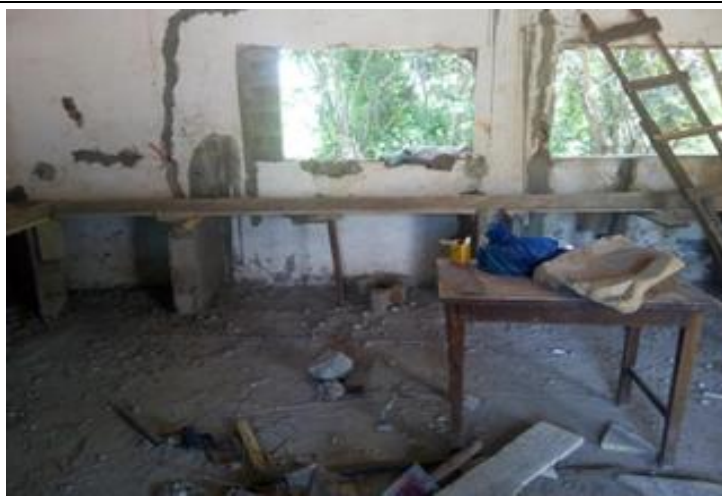
A : Travaux préparatoires de la construction
