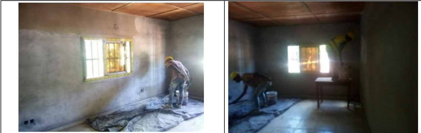
A : Début des travaux de peinture
