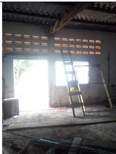
B : Pose de la toiture
