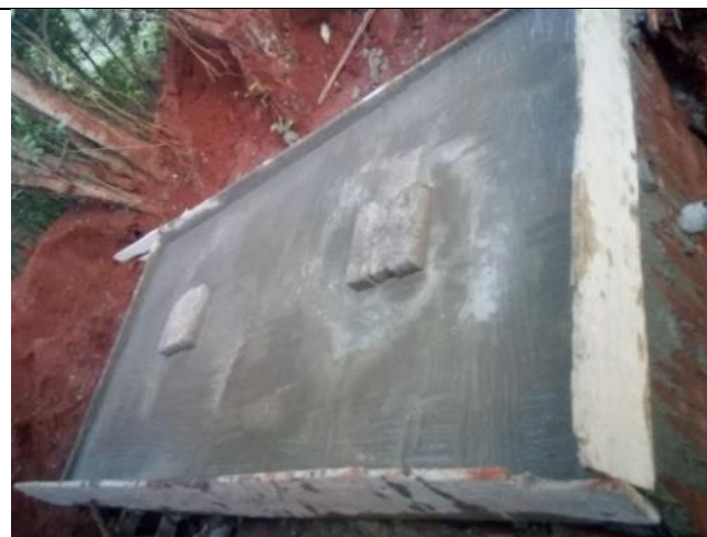
B : Fin de la construction des fosses
