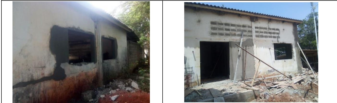
B : Fin de la fermeture des fissures et costrats
