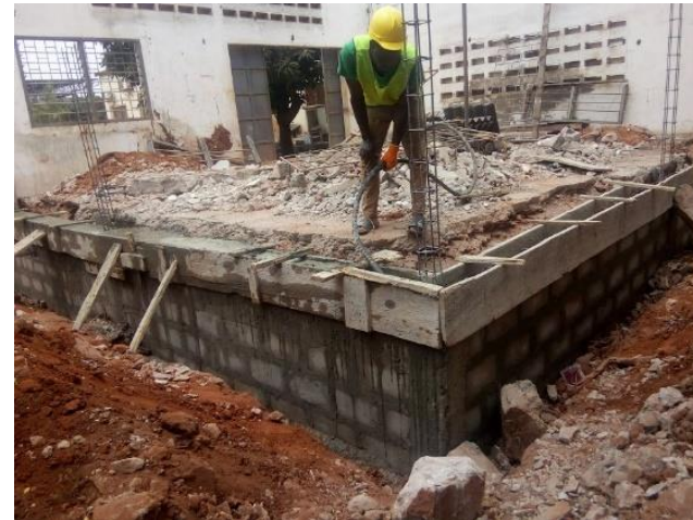
D : Pose de la longrine et vibration
