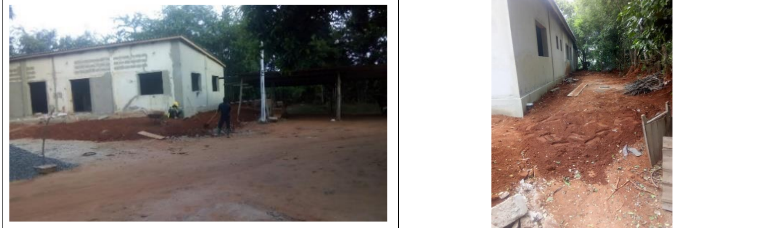
A : Fin de la réalisation de l'enduit ciment
